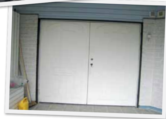
Perheen autotalli oli ennen remonttia varastona. Ovien tilalle vaihdettiin saman levyinen ikkuna.
